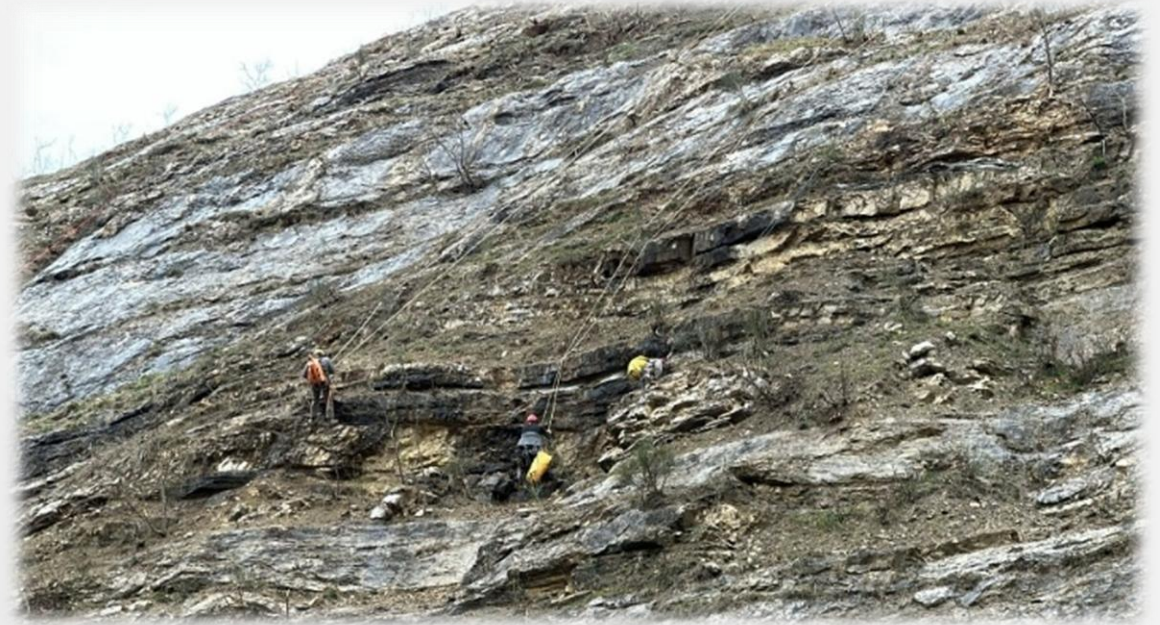
Operazioni di disgaggio
