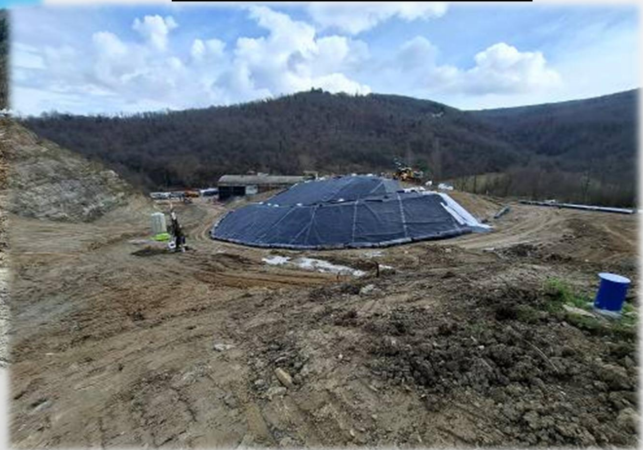
Posa teli AREA 2 SUD
