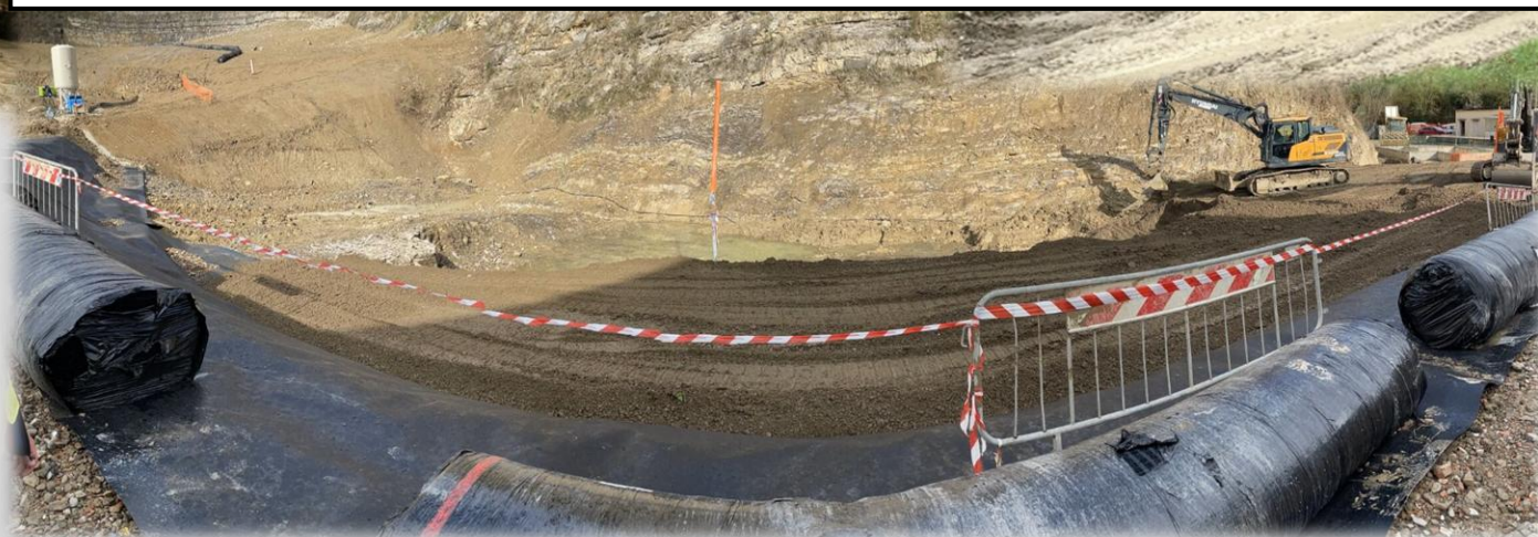
Posa telo impermeabile sponde AREA 1 e suo riempimento
