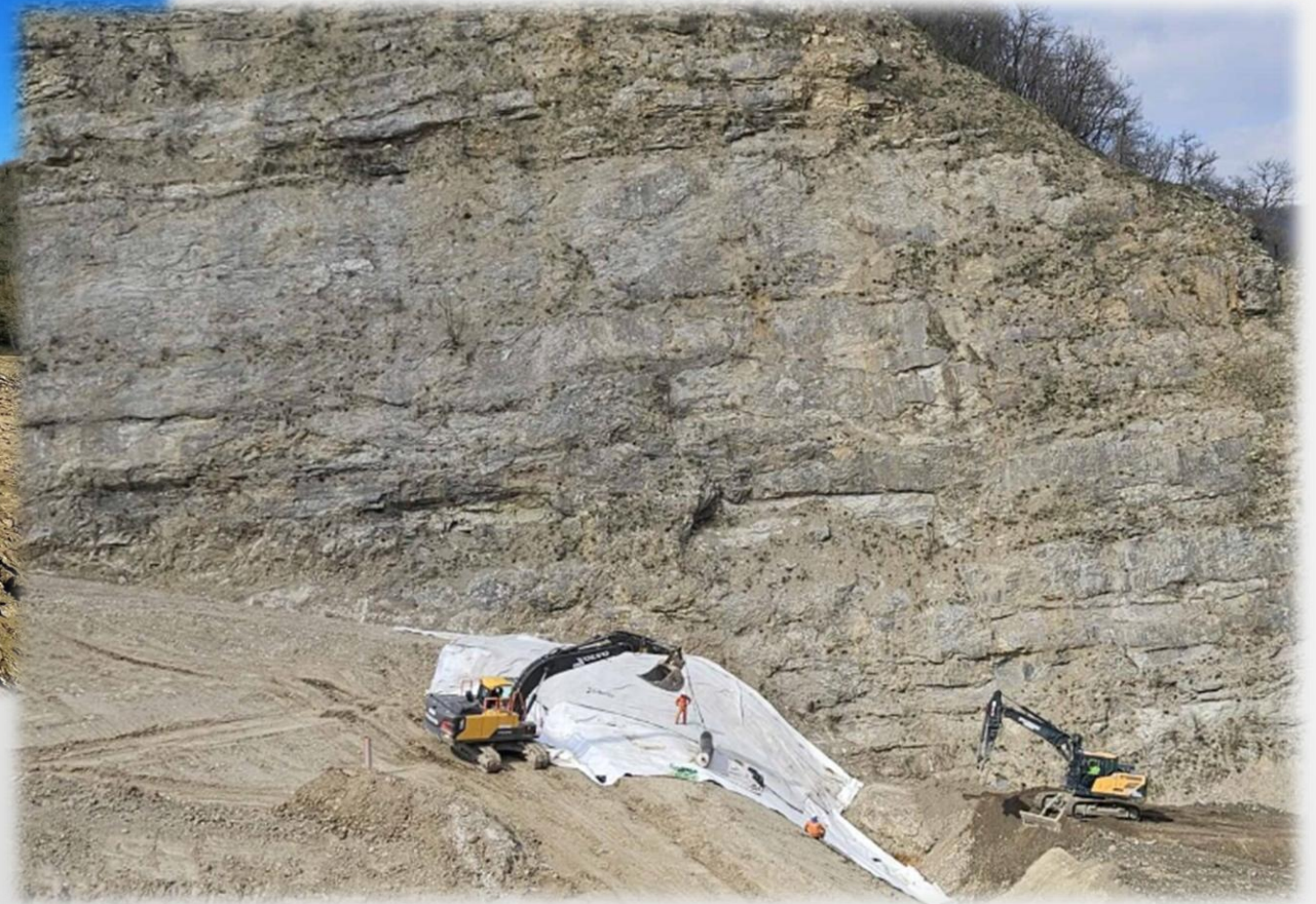
Posa teli AREA 2 NORD
